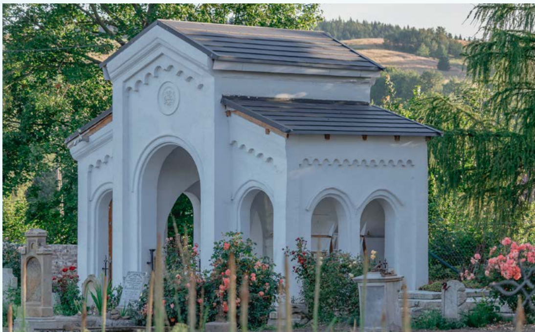
Kapelle in Gostków – Zustand nach dem Wiederaufbau
